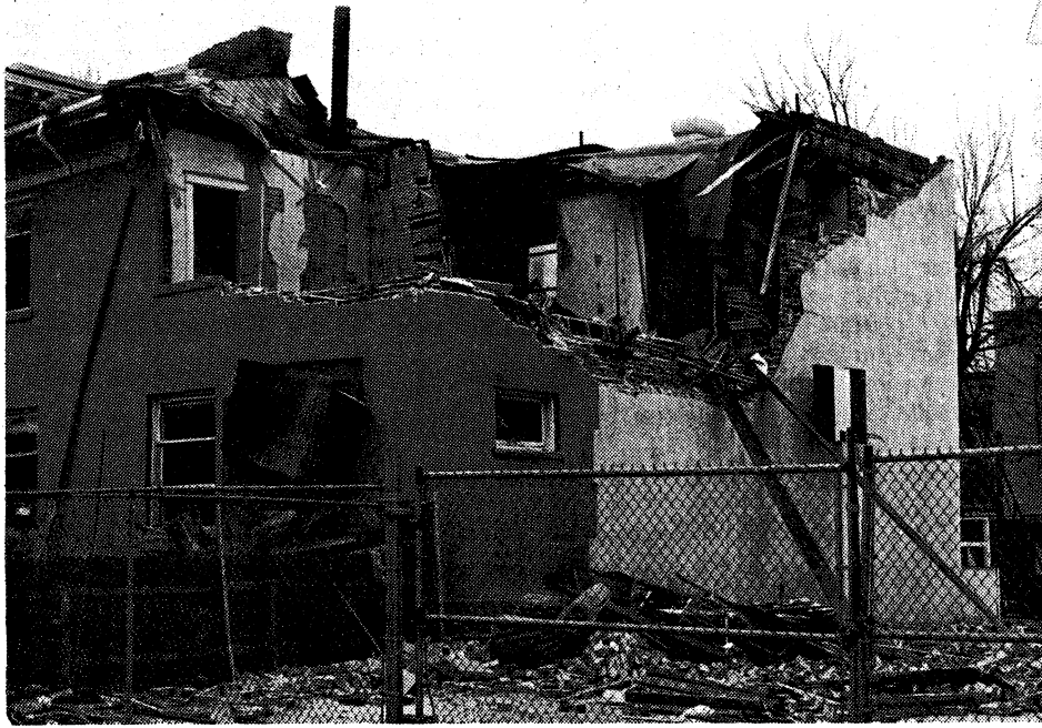
Lo que quedó de la Escuela de Tlatelolco.
