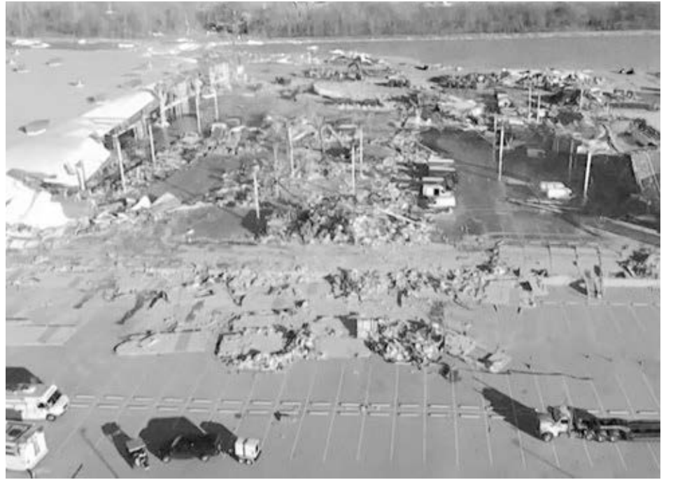
Almacén de Amazon en Edwardsville, Illinois, después de tornado. La empresa no construyó refugios seguros y trabajadores dicen que se les ordenó quedarse en la planta durante la tormenta.
