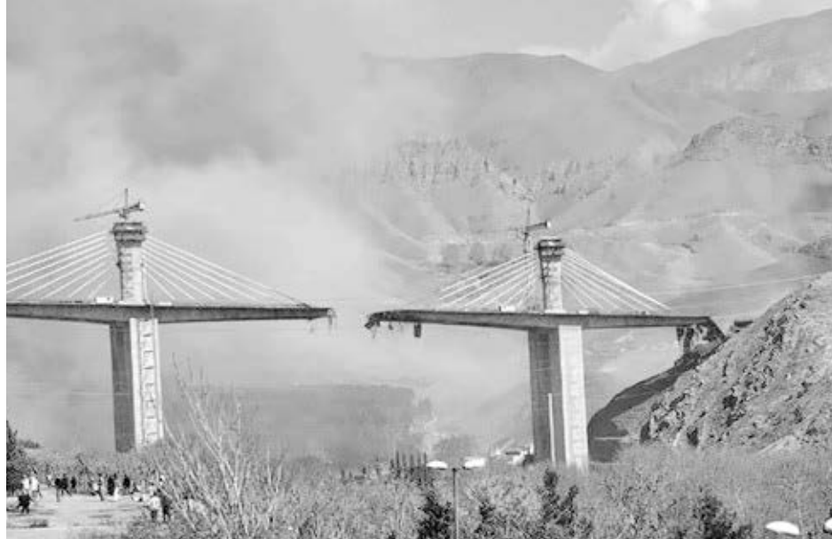
Puente bajo construcción que conecta Teherán y Karaj, Irán, fue dañado en ataque norteamericano, 31 de marzo. Washington amenazó con destruir infraestructura antes del cese el fuego.
